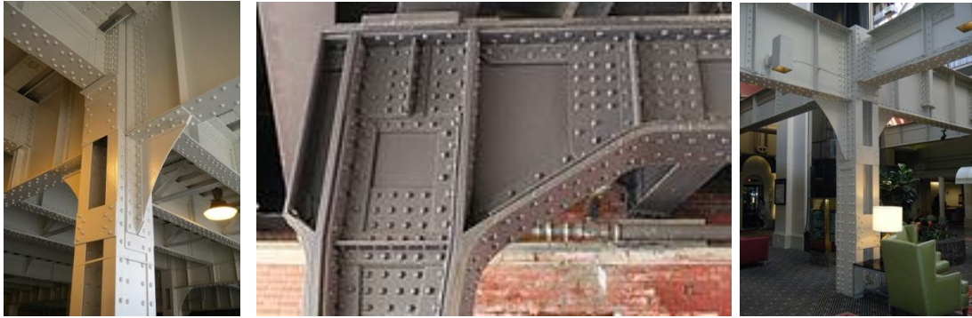
Şekil 13.10 Perçinli birleşimlerden örnekler
