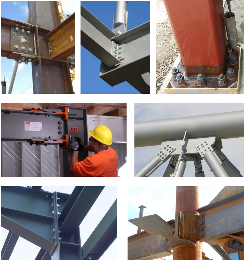
Şekil 13.6 Kiriş-kolon, kiriş-kiriş, kolon-temel ve özel birleşimlerden örnekler
